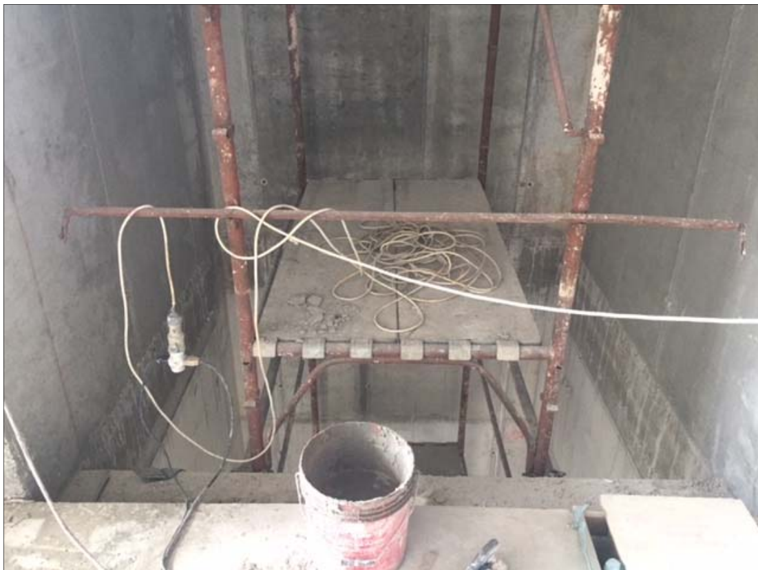
FOTO 2 – Vano corsa elevatore C: piano primo vista verso il basso
