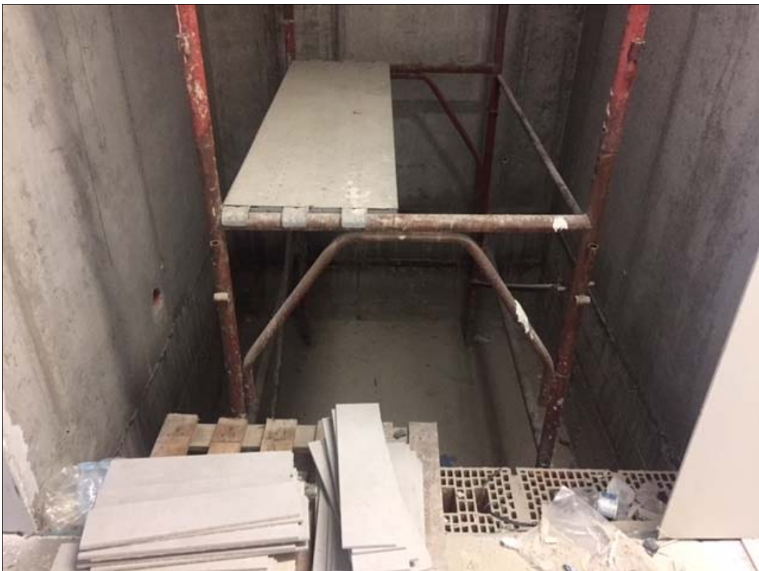
FOTO 4 – Vano corsa elevatore B: piano terra vista verso il basso
