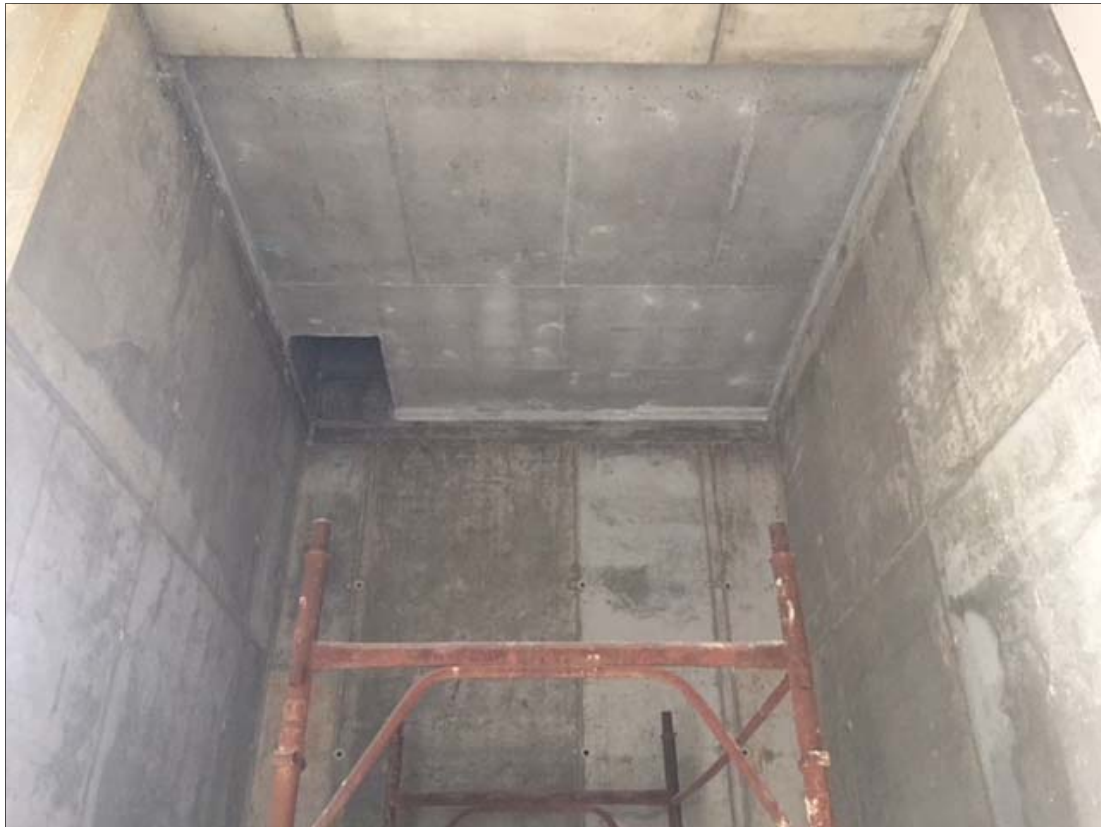
FOTO 1 – Vano corsa elevatore C: piano primo vista verso l'alto
