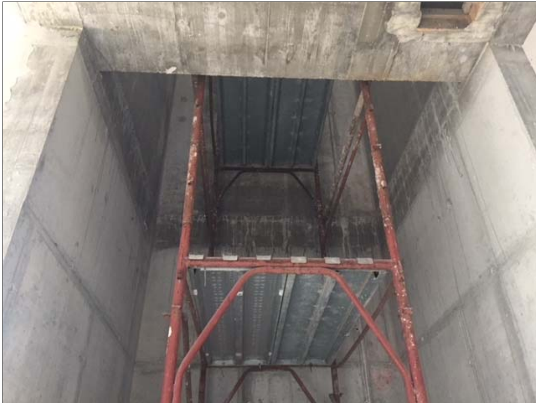
FOTO 3 – Vano corsa elevatore C: piano terra vista verso l'alto
