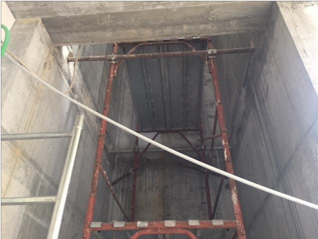
FOTO 3 – Vano corsa elevatore A: piano terra vista verso l'alto
