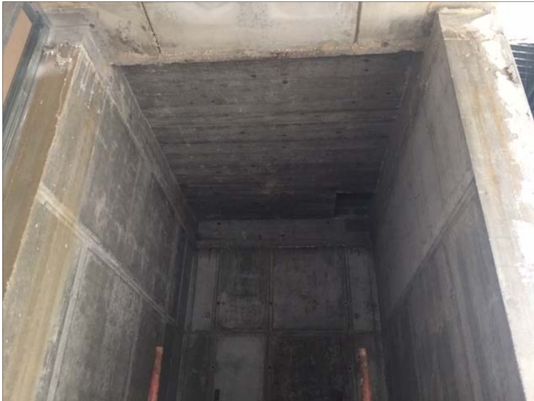
FOTO 1 – Vano corsa elevatore A: piano primo vista verso l'alto
