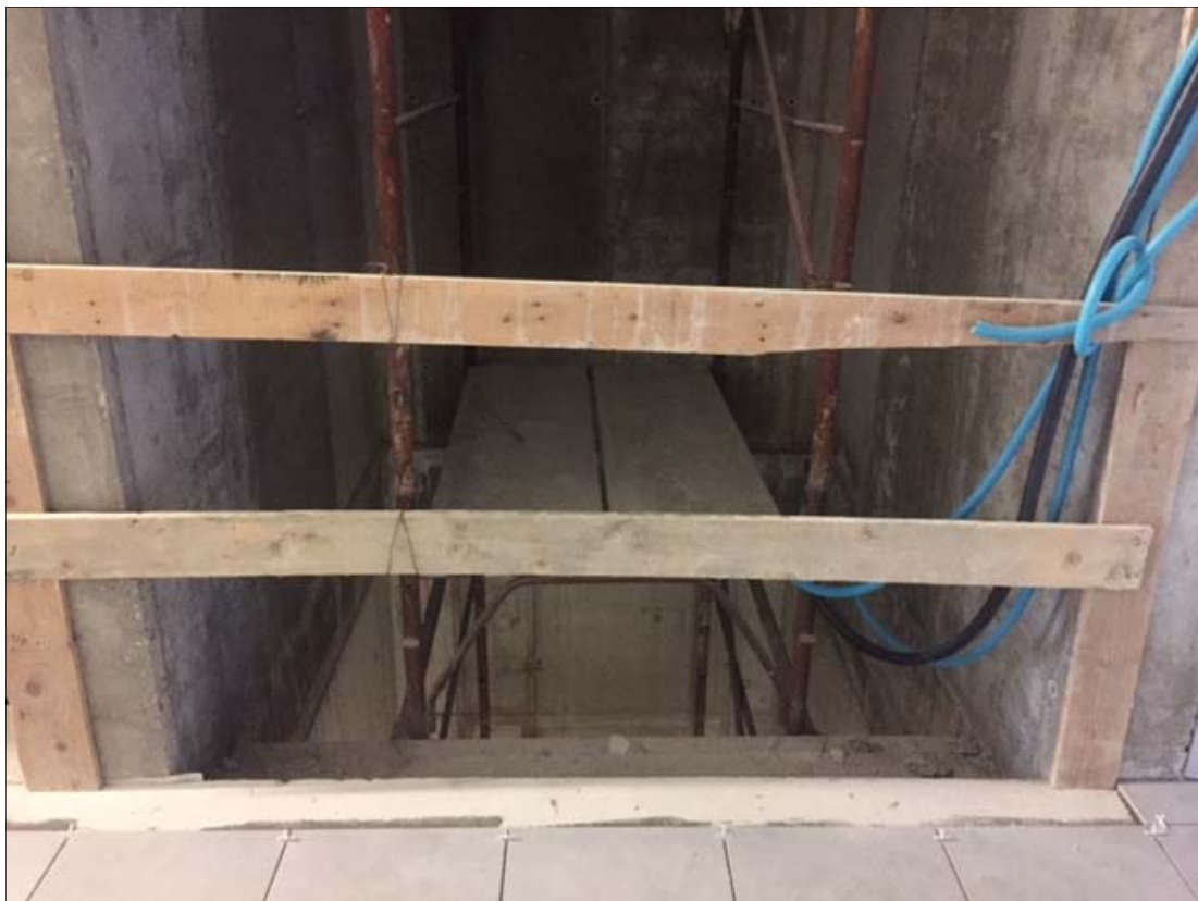
FOTO 2 – Vano corsa elevatore B: piano primo vista verso il basso
