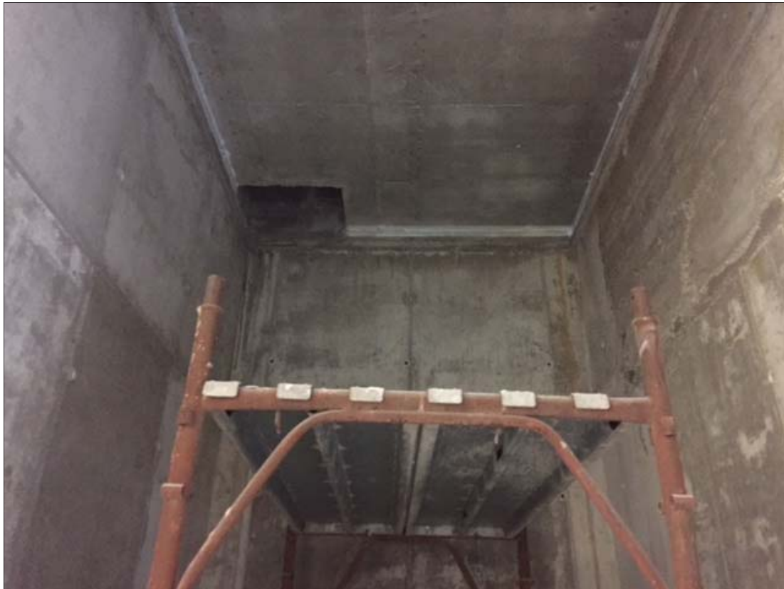
FOTO 1 – Vano corsa elevatore B: piano primo vista verso l'alto
