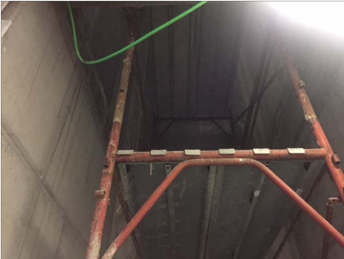
FOTO 3 – Vano corsa elevatore B: piano terra vista verso l'alto
