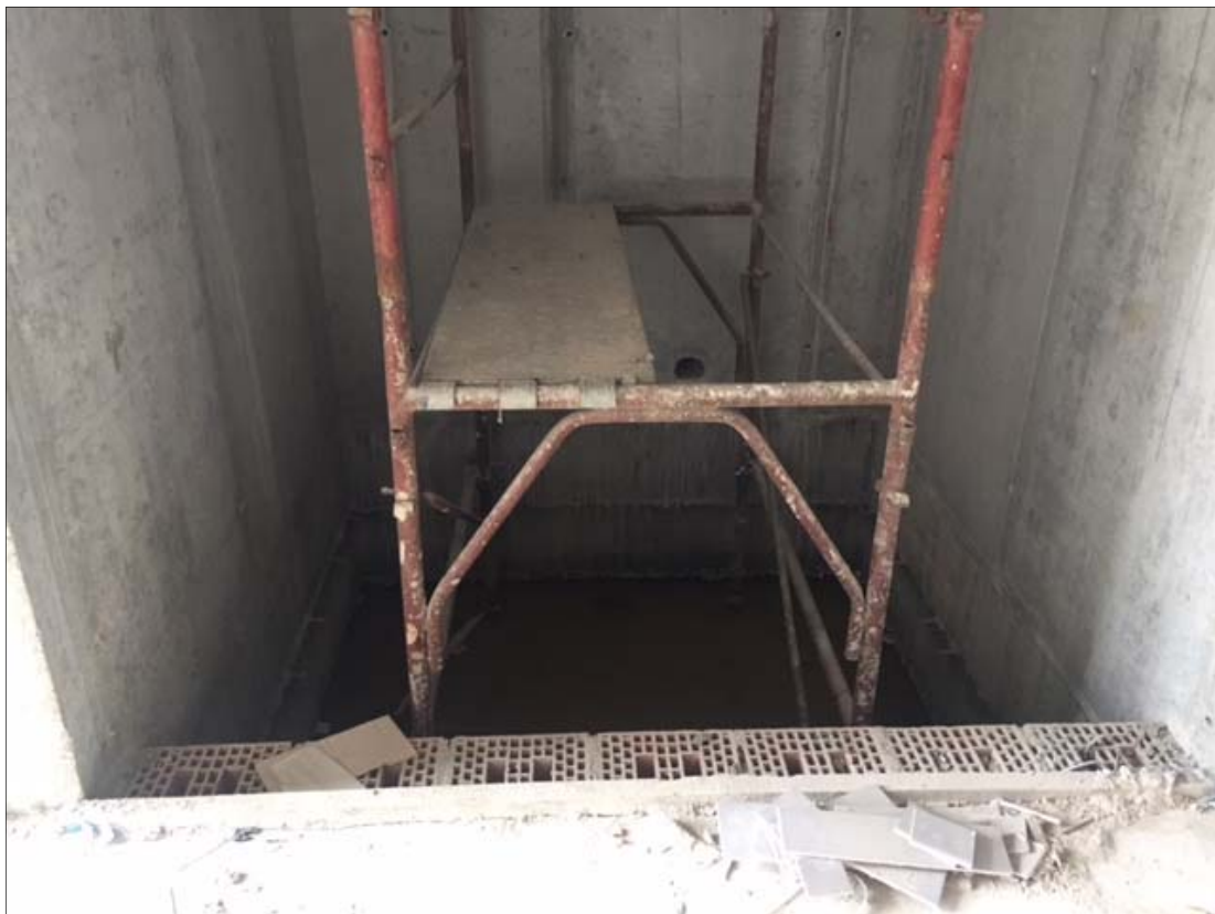
FOTO 4 – Vano corsa elevatore C: piano terra vista verso il basso
