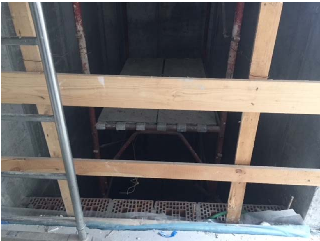
FOTO 4 – Vano corsa elevatore A: piano terra vista verso il basso
