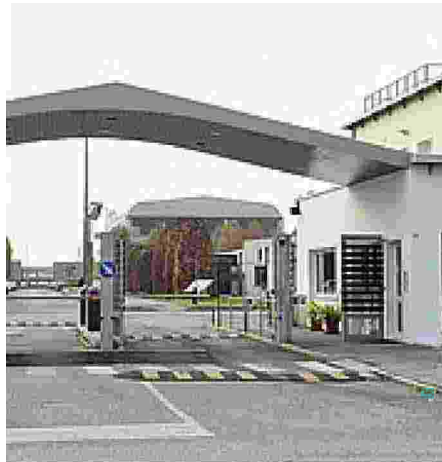
A Legnaro L'ingresso dell'Istituto Zooprofilattico. All'interno il cantiere bloccato
