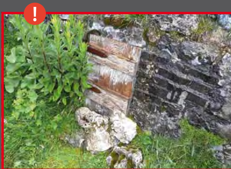
2. Messa in sicurezza della sorgente
