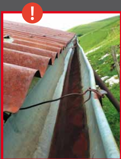
1. Verifica integrità tetto e grondaie
